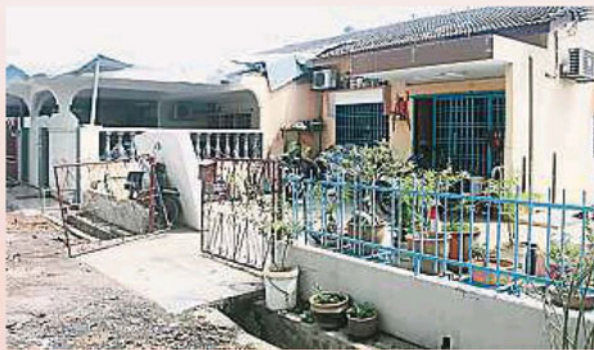
▲蔡梧桐的家园被大树压倒后，整间屋子一片狼藉。
